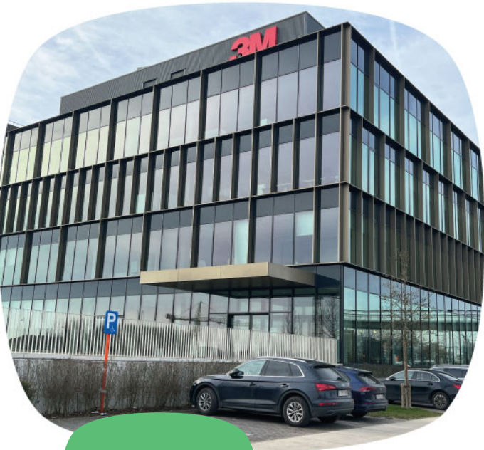
3M BRUXELLES Bureaux 4 473 m 2
