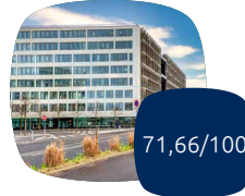
Porte d'Arcueil (Arcueil)
